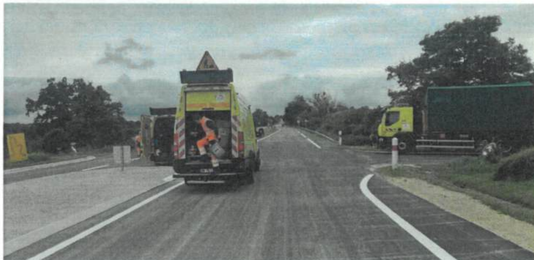
Bonne nouvelle pour les utilisateurs de la route départementale 2076, qui a rouvert mardi 2 juillet. - Conseil départemental du Cher
